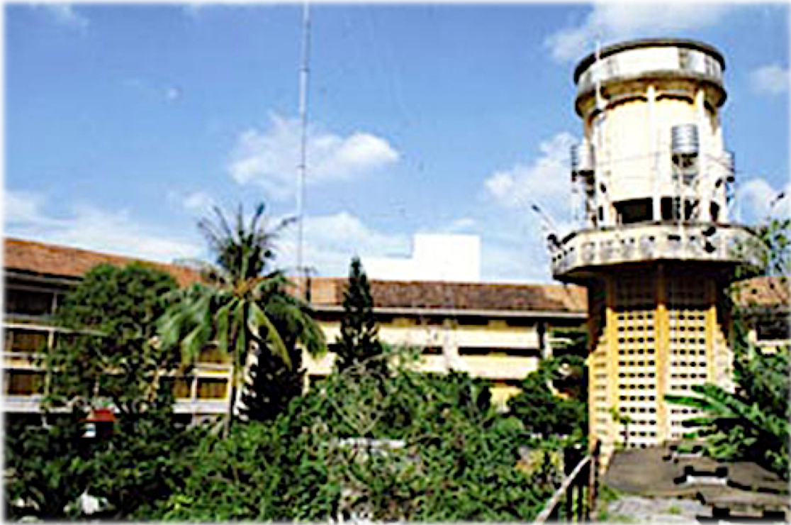
Tháp nước hình chuỗi kiềm giữa khám Chí Hòa
